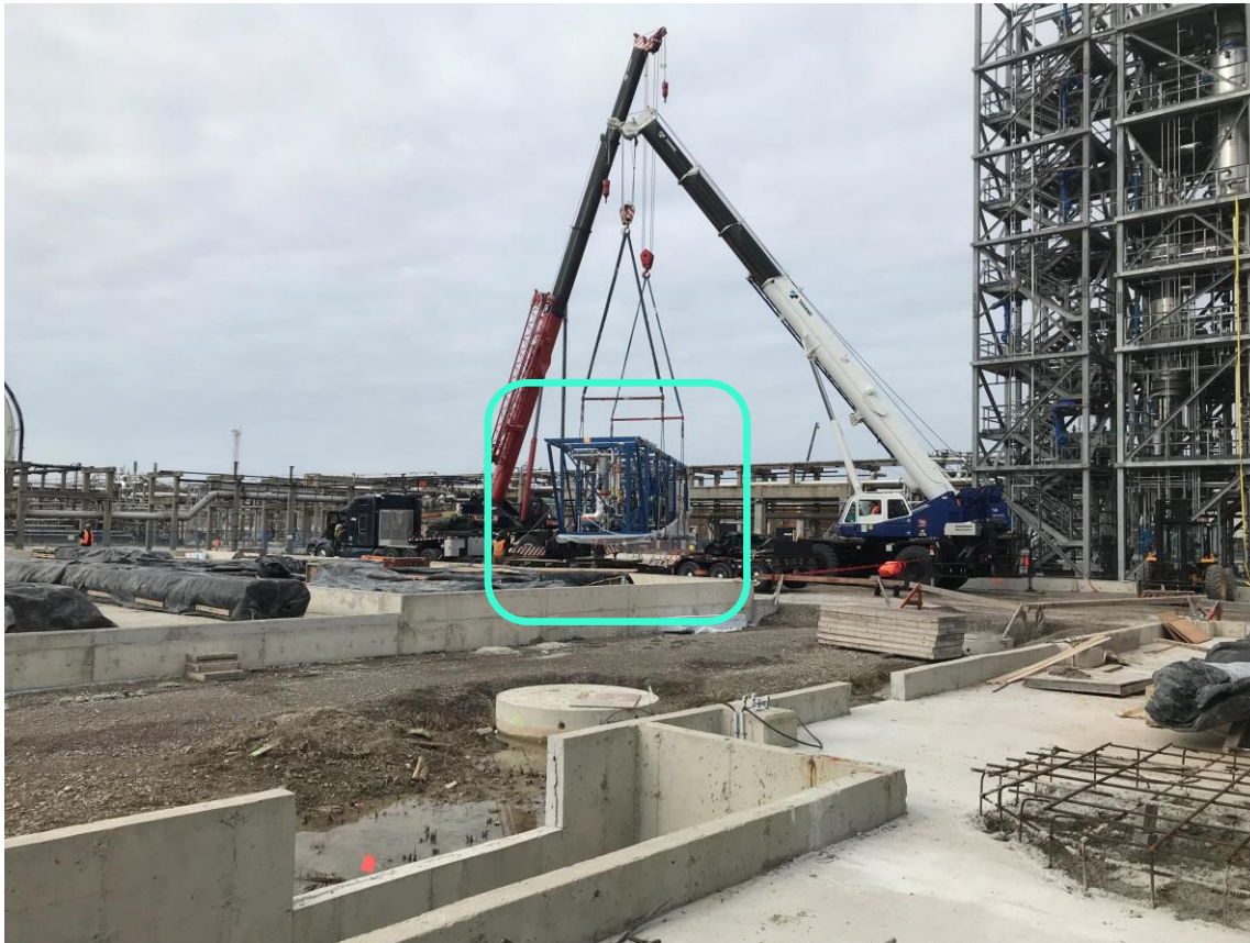
ENCON evaporator module offload
