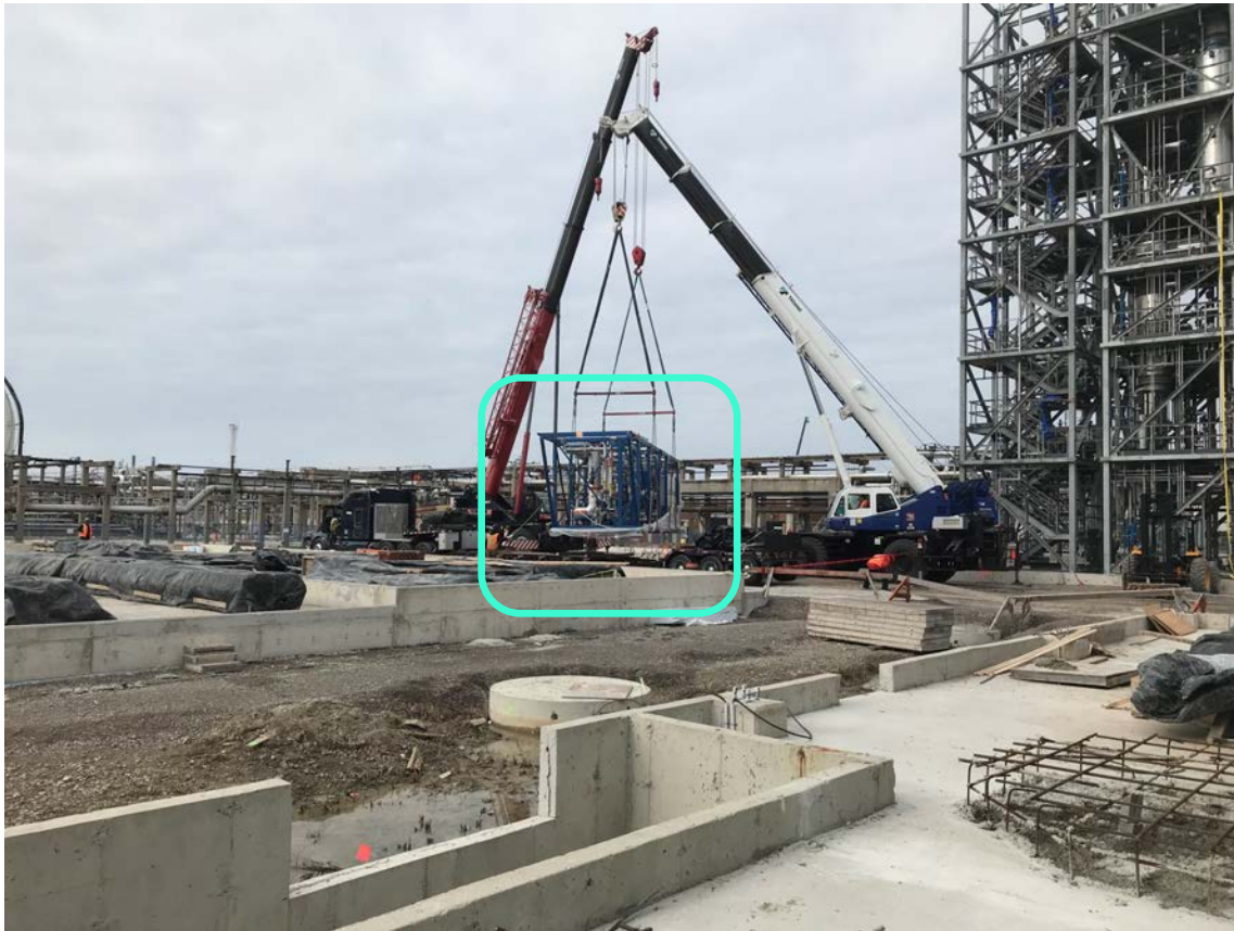
ENCON evaporator module offload
