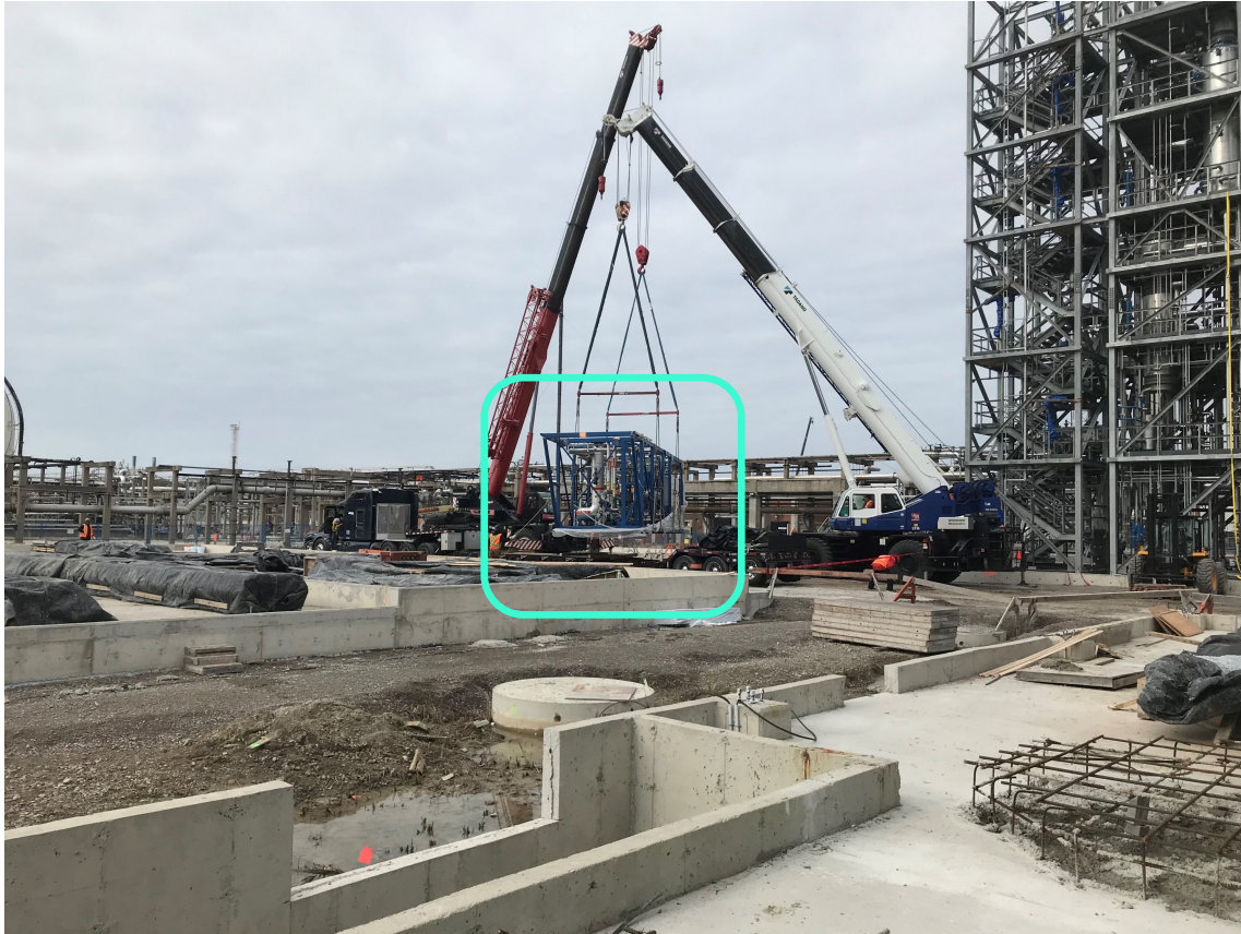
ENCON evaporator module offload
